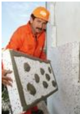
Przyklejanie płyt termoizolacyjnych do ściany (źródło: Termo Organika)
