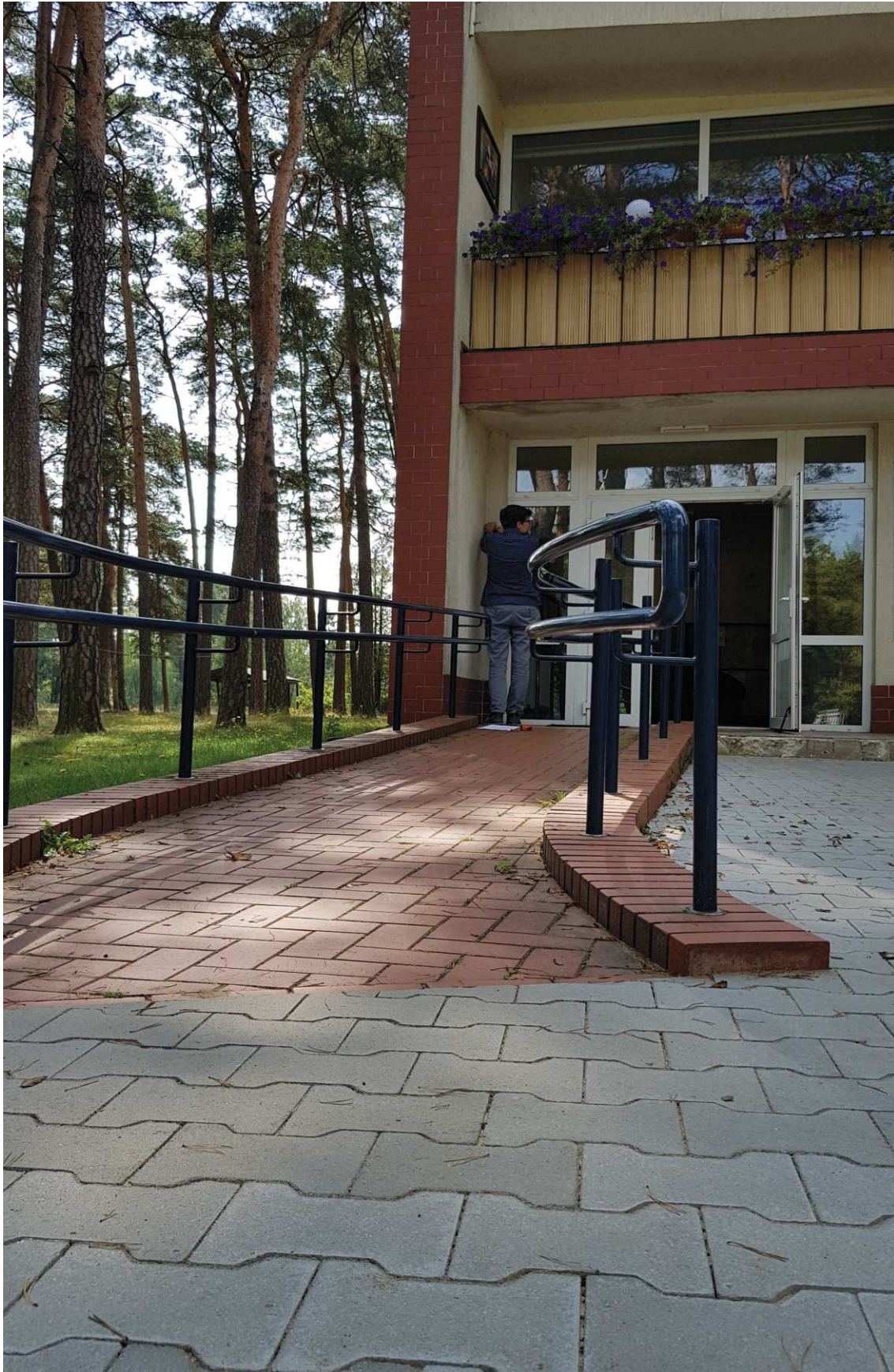
Fot.4. Fragment elewacji od strony nowej za8[budowy
