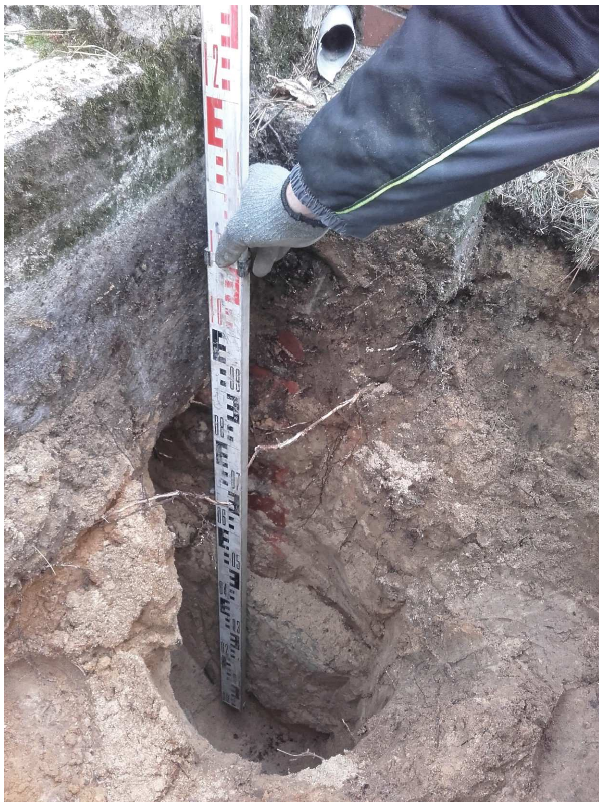
Fot.1. Odkrywka fundamentów
