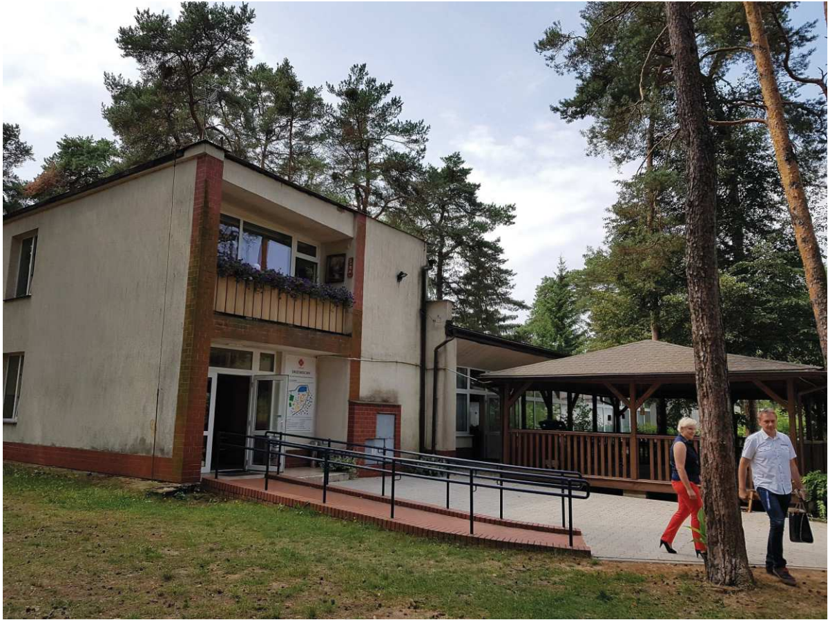
Fot.3. Fragment elewacji od strony nowej zabudowy
