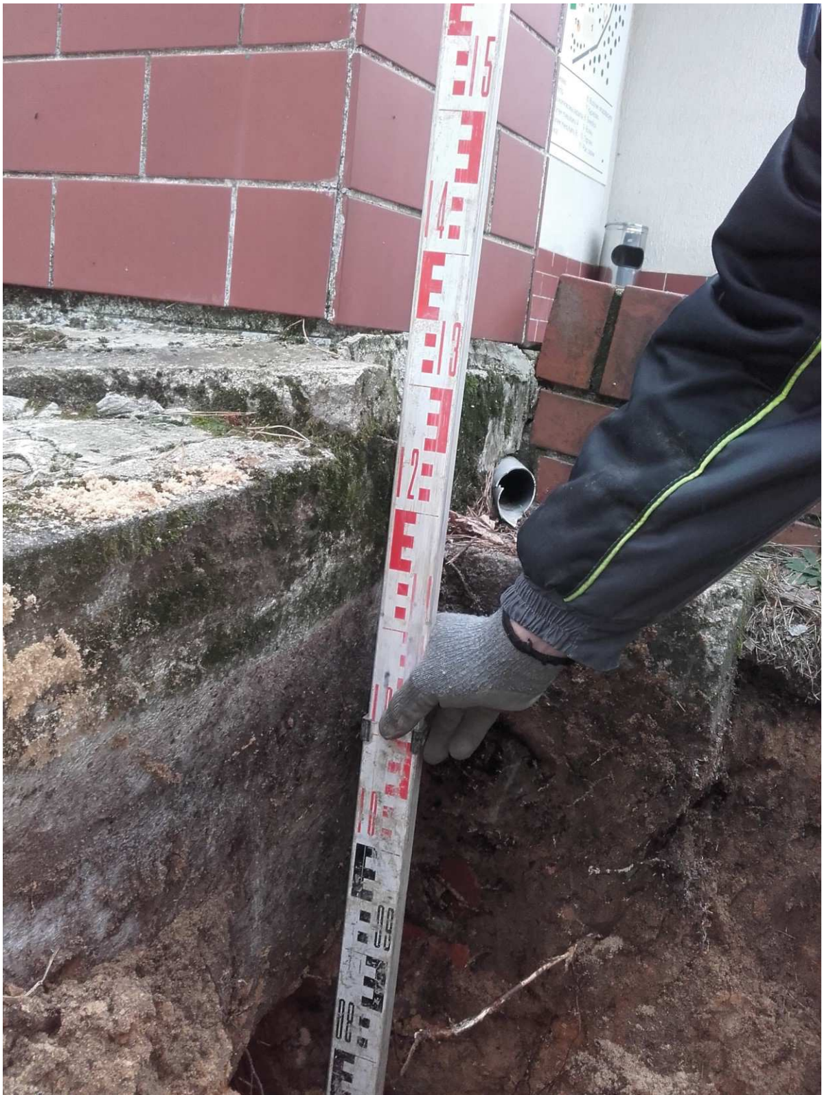
Fot.2. Fundamenty – fragment
